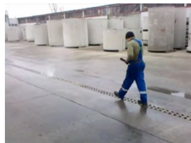
Vizuální kontrola vyčištění žlabu
