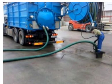
Zavedení hlavice vysokotlak. čištění
